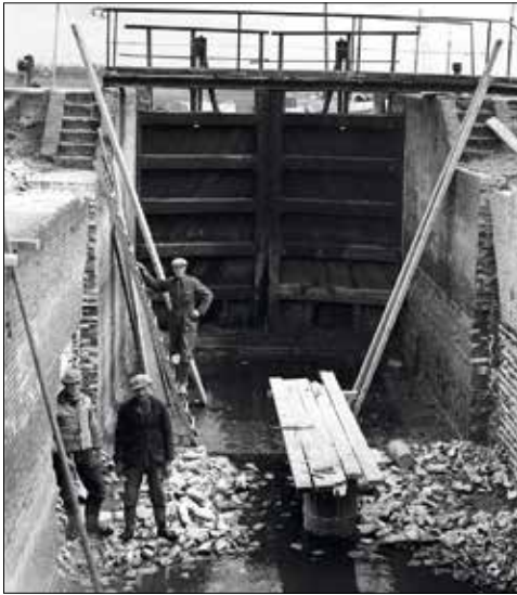
Voor de vervanging van de sluisdeuren en het herstel van het metselwerk stond de sluis in 1940 enige tijd zonder water. Foto P.A.L. van Ogtrop.
