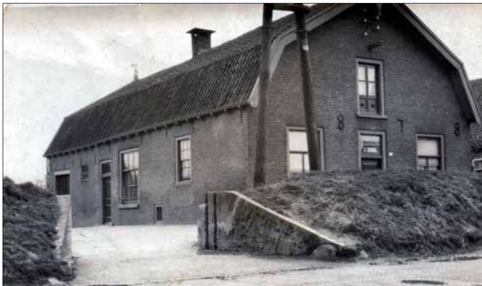
Bakkerij Wakkerendijk 3, gebouwd in 1878. Foto 1934.
