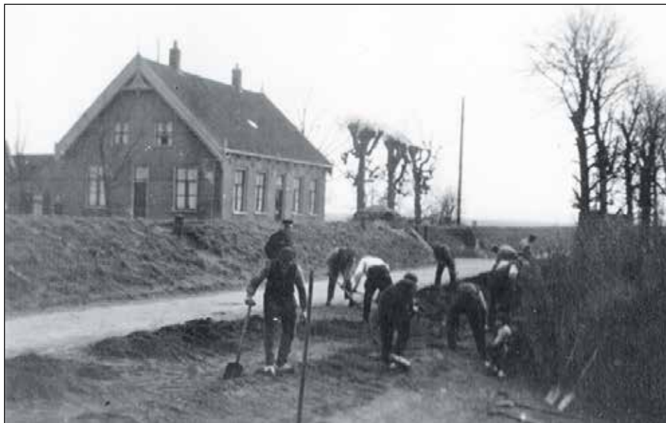
Aanleg waterleiding 1932, tegenover Wakkerendijk 29.
