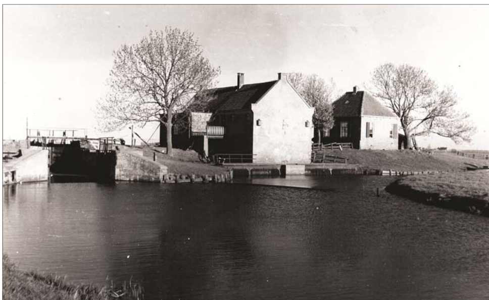
De Eemnesser Sluis met het gemaal en de oude machinistenwoning, indertijd bewoond door de familie Prinsen. Foto circa 1940.
