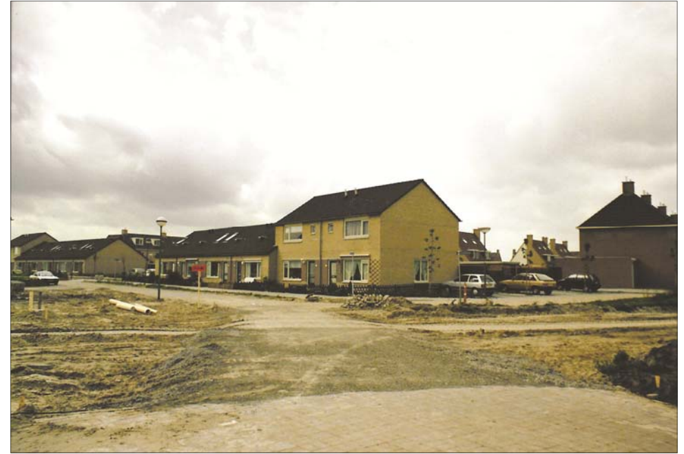
1990. Vanaf het Schoolpad zie je in het midden van de foto het pand van Binder 2 en 4. Daarnaast de seniorenwoningen. Tussen het Schoolpad en de Binder ligt de Stadijksingel (in aanleg).
