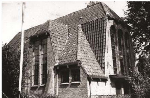
De voormalige gereformeerde kerk aan de Kerklaan in Laren.
