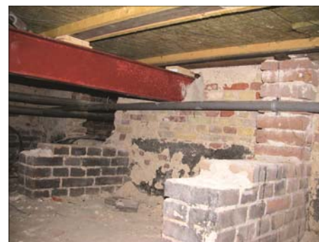
Foto van de restanten van de onderbouw van de bakkersoven op de oude tegelvloer van de bakkerij zoals deze nu nog onder de huidige vloer aanwezig is.
