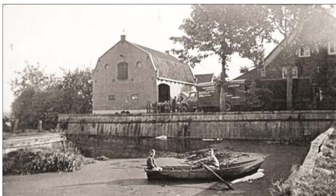
De tweede havenarm omstreeks 1935. Rechts de woning Wakkerendijk 27 met achter de vrachtwagen deels zichtbaar de aanbouw onder het lessenaardak. In het midden het in 1916 gebouwde pakhuis met daarachter de paardenstal.
