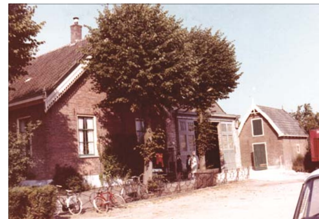
Foto uit 1970 van de zuid-gevel van het pand. Rechts de paardenstal en daartussen de aanbouw uit 1960.
