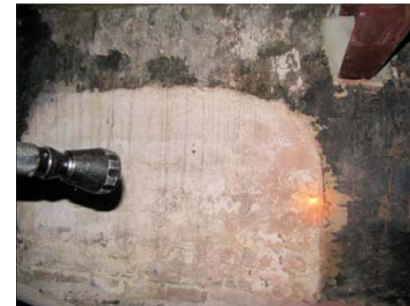
Foto van de dichtgemetselde opening van de brandstoftoevoer voor de bakkersoven. Ook deze is met andere onderdelen, nog onder de huidige vloer aanwezig.
