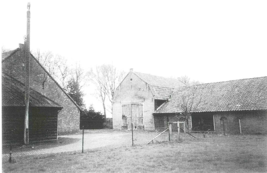
Achter de boerderij staat nog een grote los gebouwde stal met dwars geplaatst deel voor opslag van werktuigen. Sedert de dertiger jaren is hier heel weinig veranderd.
