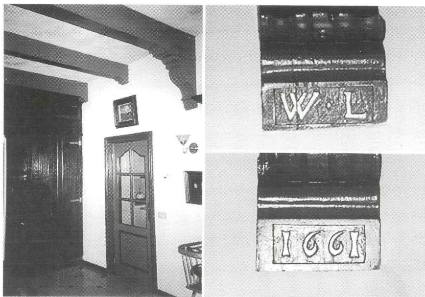
Foto 2: In de noord-westhoek van de grote voorkamer staat de eikenhouten ombouw met ribprofiel, waarachter vroeger de trap en nu een kast. De bint toont aan de uiteinden het jaar van de bouw 1661 en de initialen van de opdrachtgever WL, waarvan een close-up hierbij is afgedrukt.
