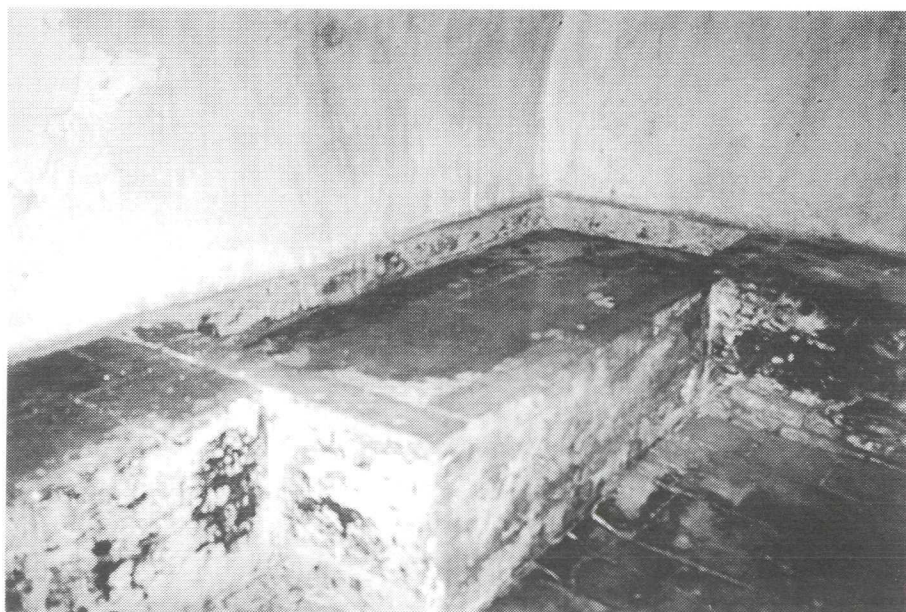
Foto 4: De kelder heeft nog de originele pekelbak, waarin vroeger het vlees werd geconserveerd. Het is een gemetselde stenen bak van 160 x 65 cm met een diepte van 10 cm; ongeveer 40 cm boven de vloer van rode plavuizen.
