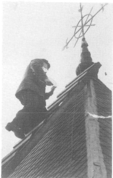
Hendrik Kuiper (1896-1974) plaatst eigenhandig het haantje op de toren van de NH-Kerk van Eemnes-Buiten. Foto van 22-10-1954.
