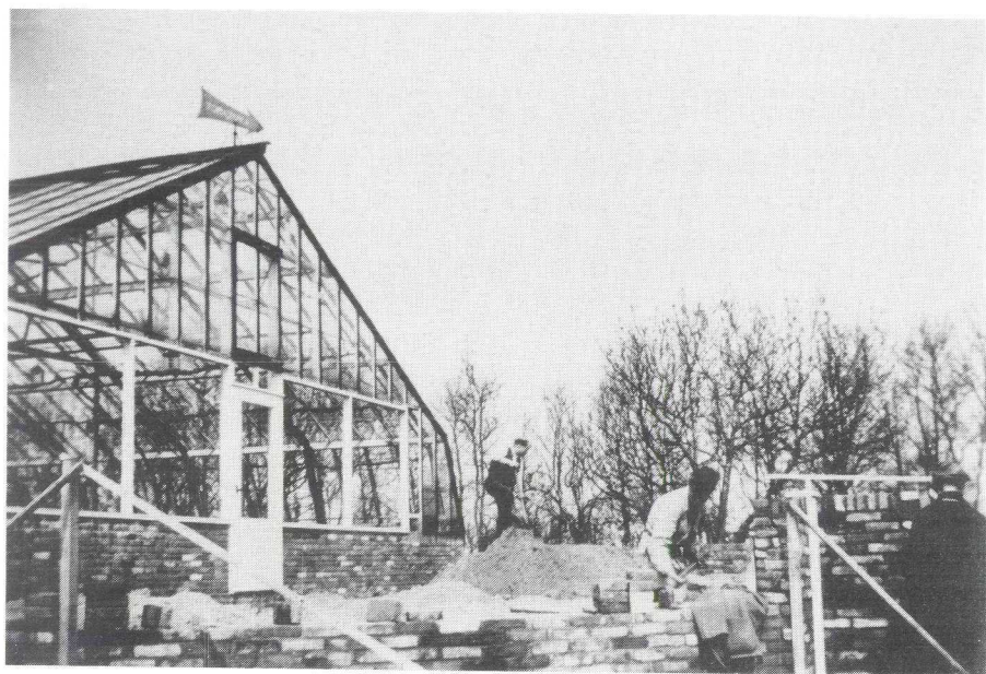
Opname van de verbouwing van de restauratiekas van Tomatuva in april 1956. De kas werd opgehoogd en er kwam een stenen trappetje met verhoogd terras voor. De Tomatuva-windwijzer is hier duidelijk zichtbaar.
