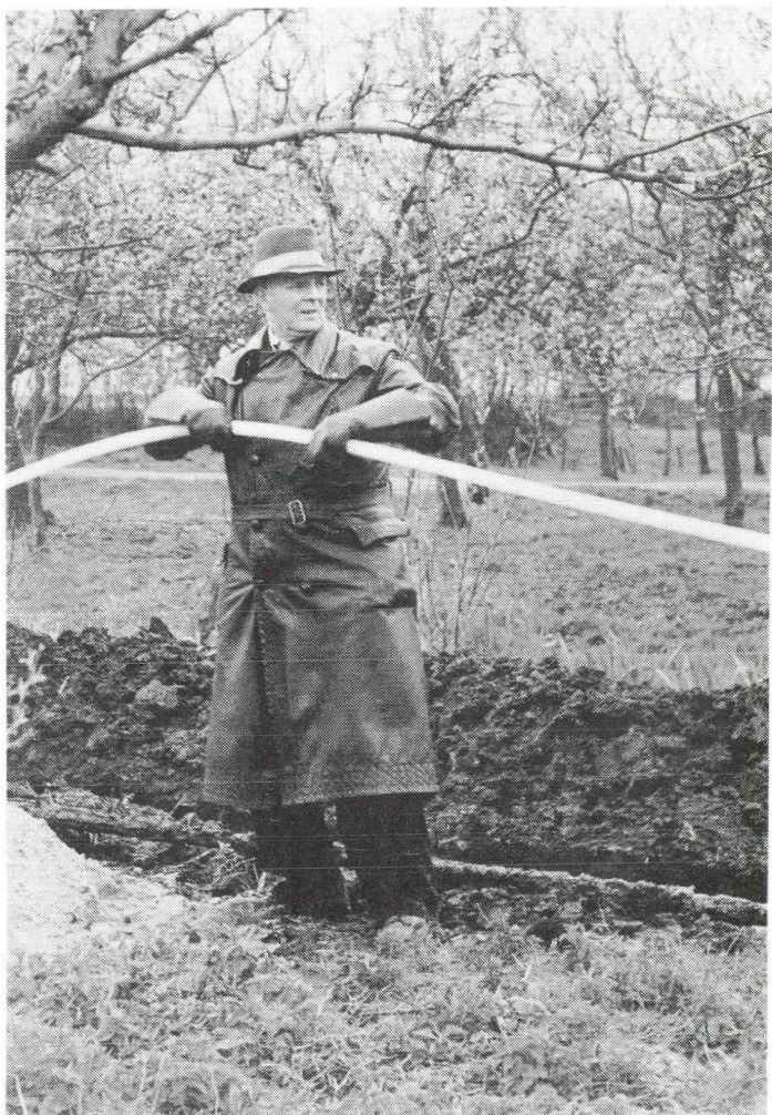
Bertus Groen in 1957 bij de aanleg van een waterleiding (VIIa)
