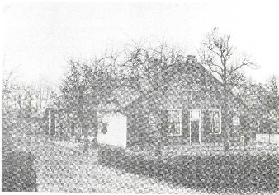
Meentweg 45 in 1967. Bij de verbouwing in 1972 is in de linkerzijgevel een tweede raam aangebracht. (foto Rijksdienst voor de Monumentenzorg)
