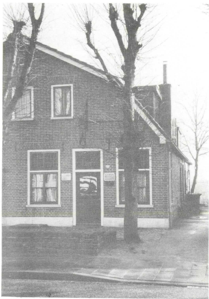
Het huidige Café Staal, Wakkerendijk 21-23, waar de brand van 1885 begonnen is.
