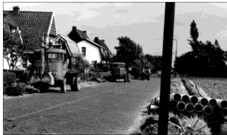
2. Aanleg riolering gezien ter hoogte van Laarderweg 96.
