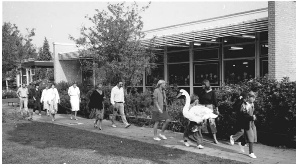
Basisschool De Zuidwend in 1983. De kleuters van Zwaan Kleef Aan op weg voor de opening van het nieuwe gebouw voor hun schooltje. Hier staat sedert 2010 het appartementengebouw de RaadsVore (foto Peter Scholte).
