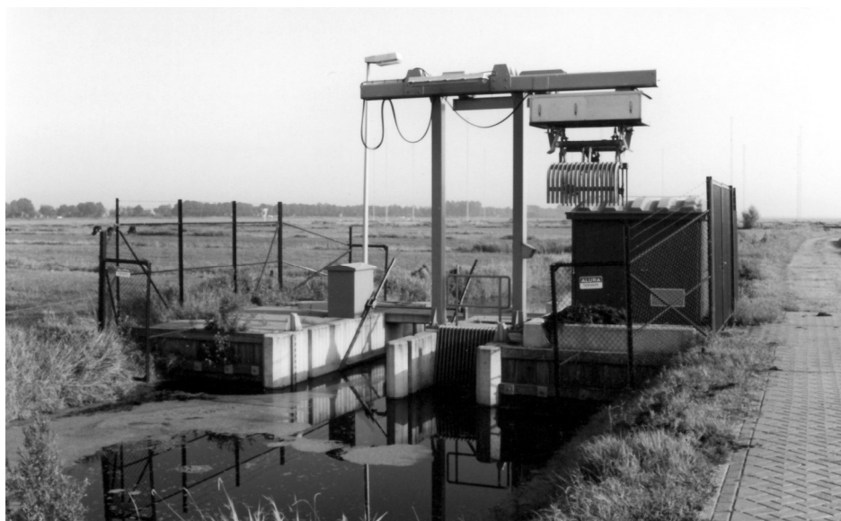
Voor natuurbehoud kwam het nieuwe gemaal Volkersweg naast het Marinestation. Doel: hoger zomerpeil in de Noord Middenwetering. Foto 1997.
