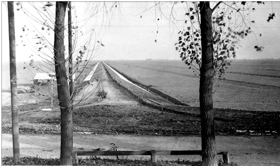
Zicht vanuit het bovenraam van Wakkerendijk 164 op de Jonge Jaapeweg in aanleg in november 1939. Burgemeester Van Ogtrop schreef achter op de foto: sloten gegraven; zandkip nog niet gestort.
