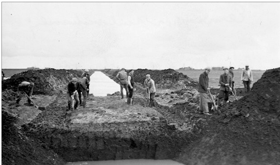
Het graafwerk was uitsluitend handwerk, grotendeels door te werk gestelde werklozen. Hier aanleg van de nieuwe Maatwetering in oktober 1940.
