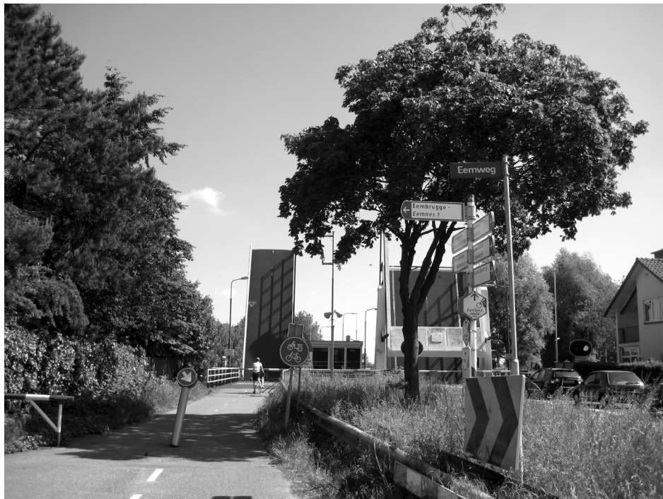
De brug bij Eembrugge.
