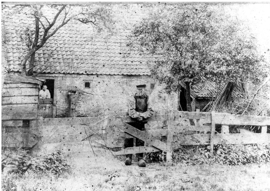
Foto van de oude woning Wakkerendijk 164, gesloopt ca. 1922. Het was een dwarshuis dat strak langs de weg stond en met de voorzijde naar de driest gericht was. De huidige woning is er rond 1922 achter gebouwd. Hier woonde de familie Van der Zwaan van 1784 tot 1923. Aan het hek staat Tijmen van der Zwaan (1846-1921).
