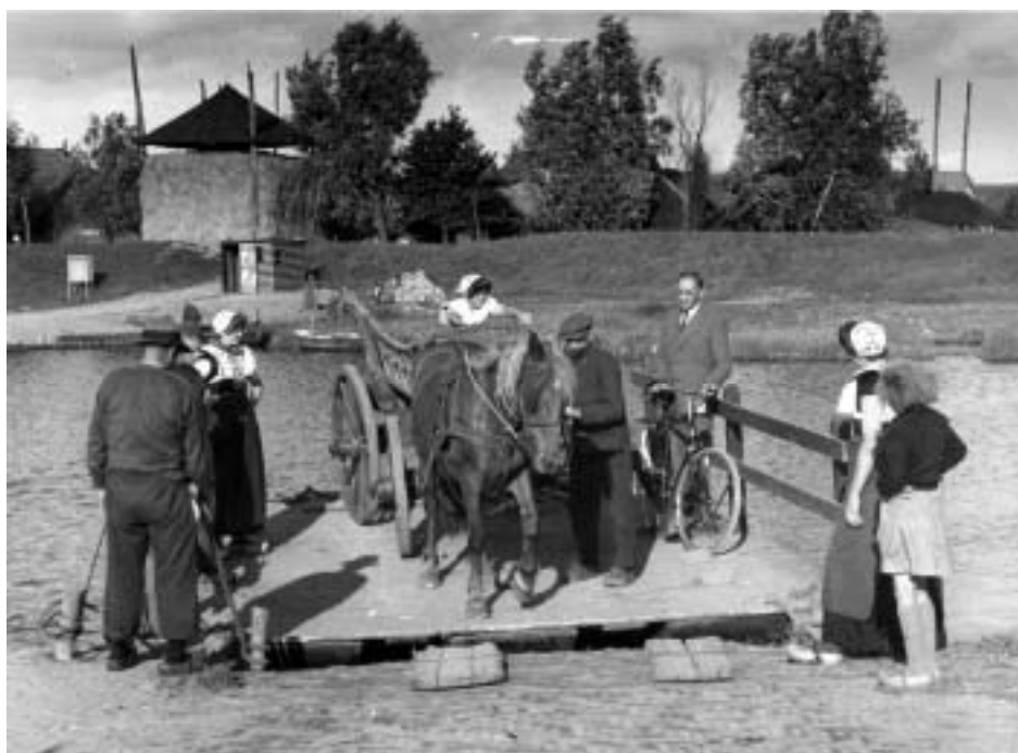
Dit is het pontje van Peter Varenkamp in 1948. Het heeft hier al drie bootjes als drijvers. Met handkracht trok men de pont langs een kabel naar de overkant. Het overzetten van paard-en-wagen was een heel gedoe, waarvoor men de hulp vroeg van omwonenden. Bij terugkeer van een wagen met hooi, werden de beladen wagen en het paard afzonderlijk overgevoerd (foto Van Heemskerck Düker; uit collectie Arie ter Beek).
