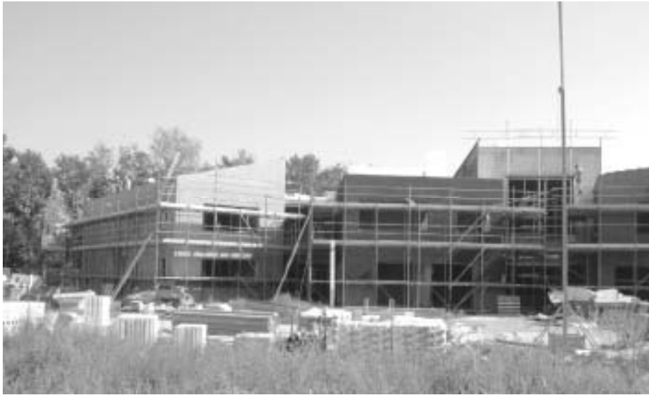
De clusterschool in aanbouw (2006).
