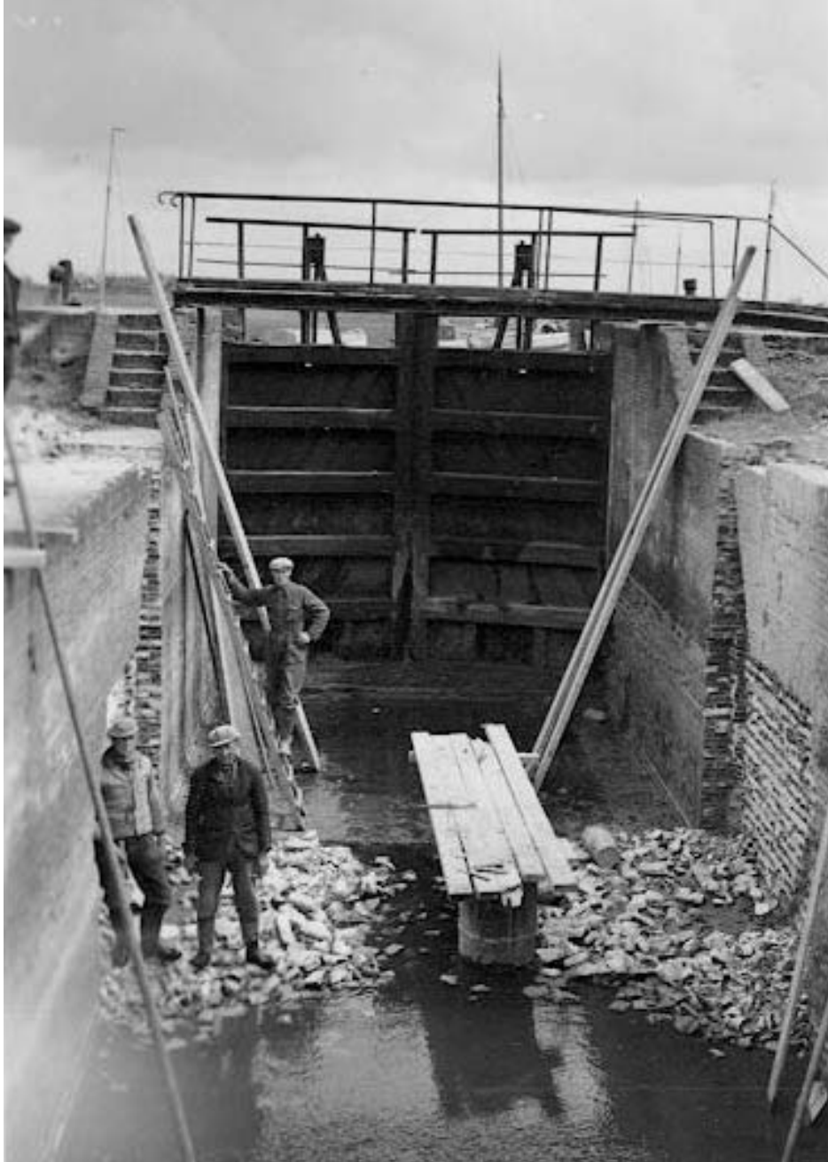
Betonwand sluis: in de jaren 50 werd de sluis afgesloten met een betonnen keerwand
