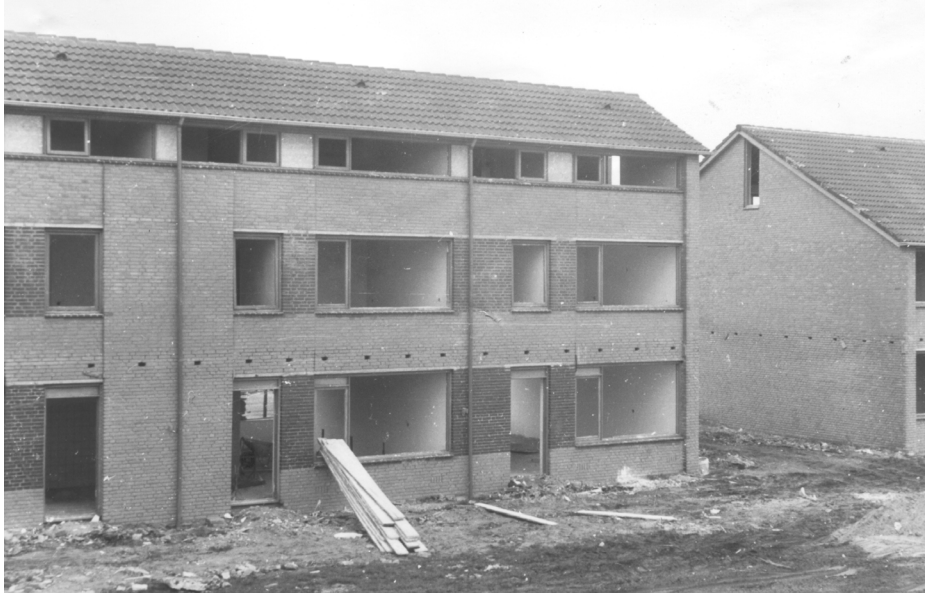
De achterzijde van Ploeglaan 34 t/m 38 (links) in 1971. Net uit de steigers. Eén van zulke steigerplanken heb ik kunnen uitgraven uit de tuin, ook die van de burens. (Fam. Groeneveld-Kaiser)
