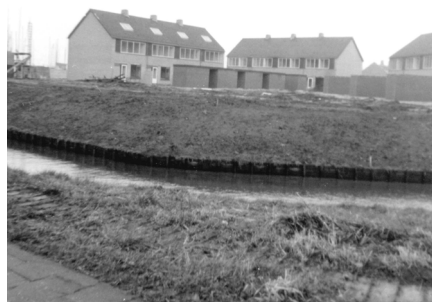
Van bouwput, met zicht op de Herv. Kerk, tot de eerste huizen van de Fazantenhof
