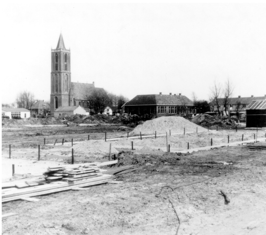
De grond voor Raadhuislaan 30 t/m 42 is bouwrijp en rechts staat de bouwkeet van aannemer Loman al klaar. Foto in april 1964 genomen door Hugo Bloemkolk, vanaf Raadhuislaan 47/49. Links bij de kerktoeren staat het tijdelijke gebouwtje van de Christelijke kleuterschool.
