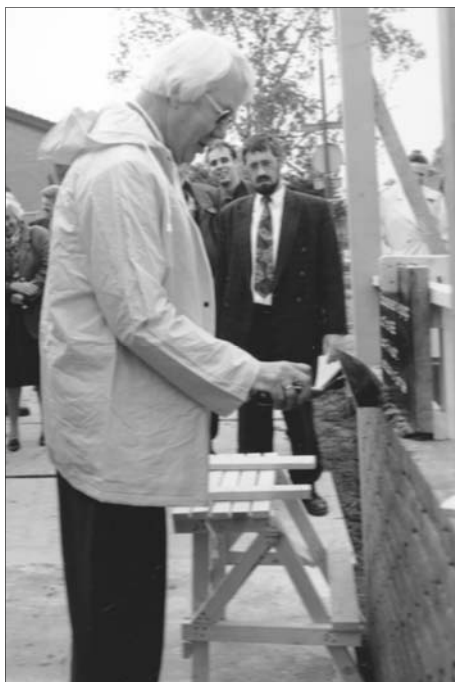
Roel Kraefft legt de eerste steen voor het Seniorencomplex De Bongerd aan de Jhr. C. Roëllaan. Foto 22-5-1996.
