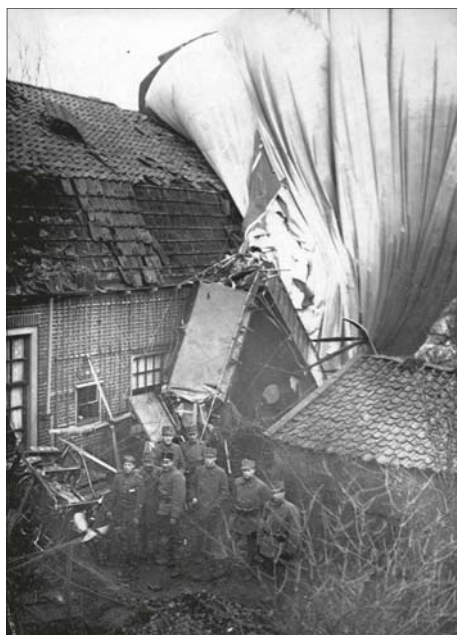
De ravage bij Wakkerendijk 3. Links vooraan een motor. Daarnaast Nederlandse militairen. Achter hen de geknakte gondel van de C26 en het anker op het dak van de schuur.
