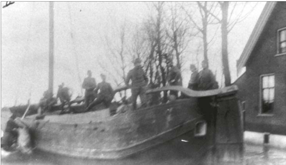
Het schip van Hendrik Kuiper in de Eemnesser haven bij Wakkerendijk 27-29. Met dit schip wilde men het gat in de dijk aan het eind van de Meentweg gaan dichten. Rechts de woning van de familie Van Ijken.
