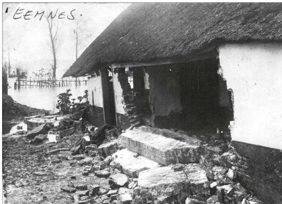
Wakkerendijk 59 Eemnes Binnen. Noordgevel verwoest.
