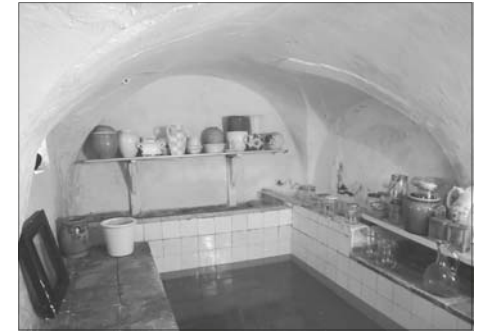
Foto 3: Meentweg 37. De kelder met aan de achterkant en rechtsachter aan de zijkant de pekelpakken.
