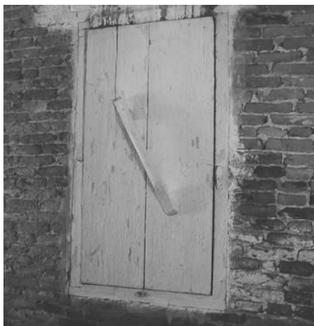
Het luik voor de rookruimte in de schoorsteen van de boerderij Meentweg 37.
