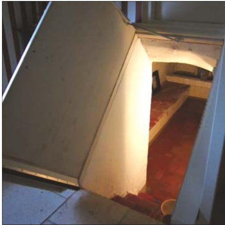
Meentweg 37. De kelder onder de opkamer. Op de deur zitten de treden naar de opkamer.
