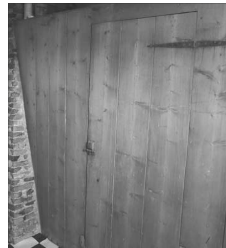
Meentweg 37. De rookkast naast de schoorsteen, waar de gerookte waar bewaard werd.
