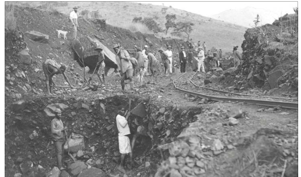
Aanleg van de spoorlijn Pretoria-Maputo, 200km van Pretoria. Foto ca. 1892.
