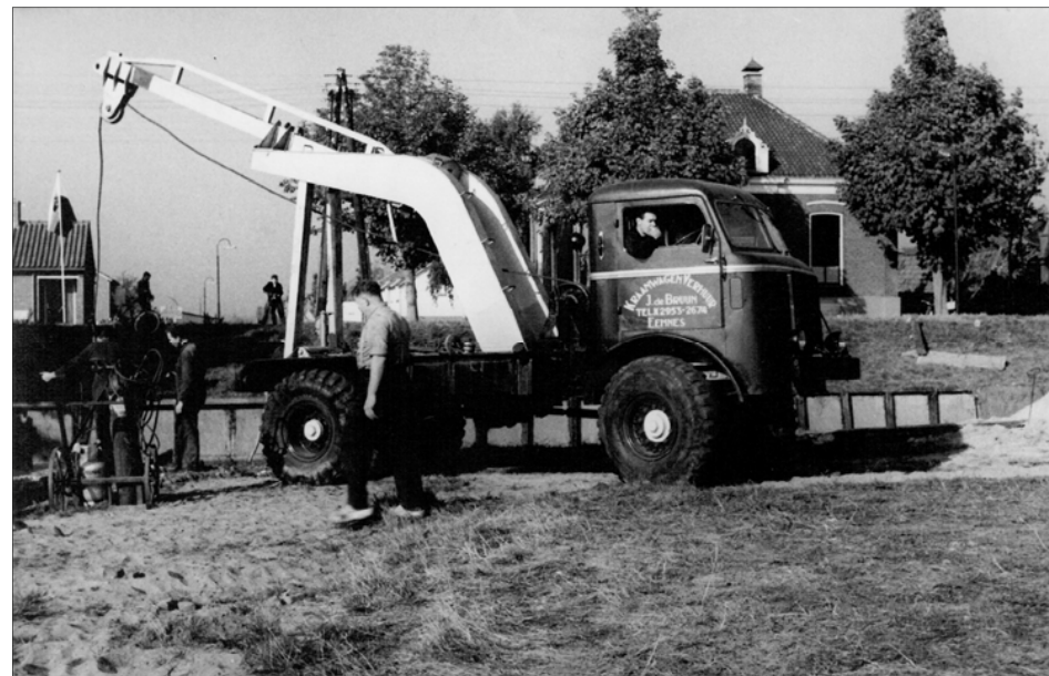
Jan de Bruijn voor zijn kraanwagen bij het dempen van de havenarm voor het toenmalige gemeentehuis. Foto's uit 1964
